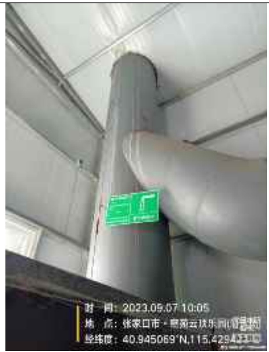
南翼公寓锅炉房 (3t/h) -14 号废气排放口
